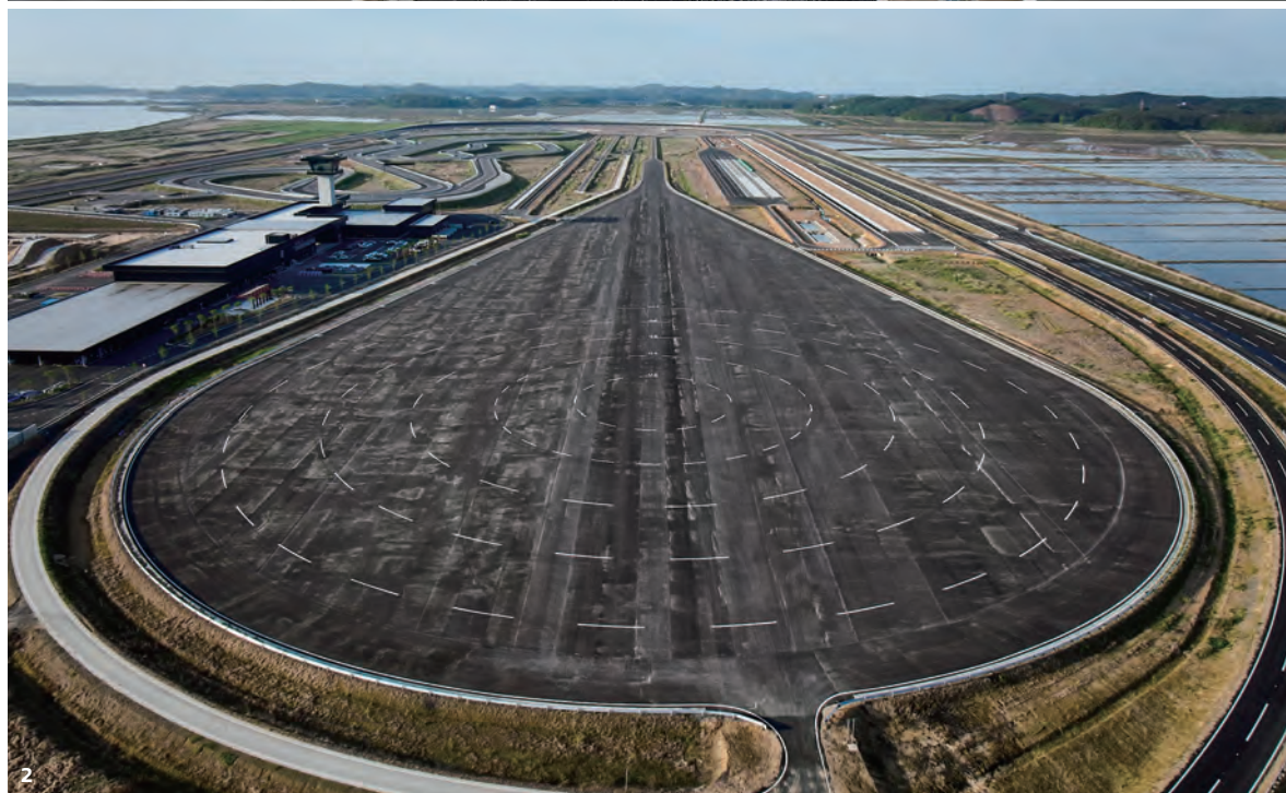
1 제동 시험로(Braking)는 마른 노면과 젖은 노면이 각각 4개 차로씩 구성돼 있고, 젖은 노면은 아스팔트와 콘크리트로 포장돼 있다. 그리고 수막 직선로(Hydroplaning Straight)가 있어서 젖은 노면에서 타이어 트레드 패턴의 배수 성능을 종합적으로 평가할 수 있다. 2 VDA(Vehicle Dynamics Area)에서는 슬라럼, 차로 변경, 원선회 등 조종 안정성과 한계 성능을 테스트한다. 최고 200km/h까지 테스트 가능하며, 원선회로(Skid Pad)의 직경은 240m나 된다.
