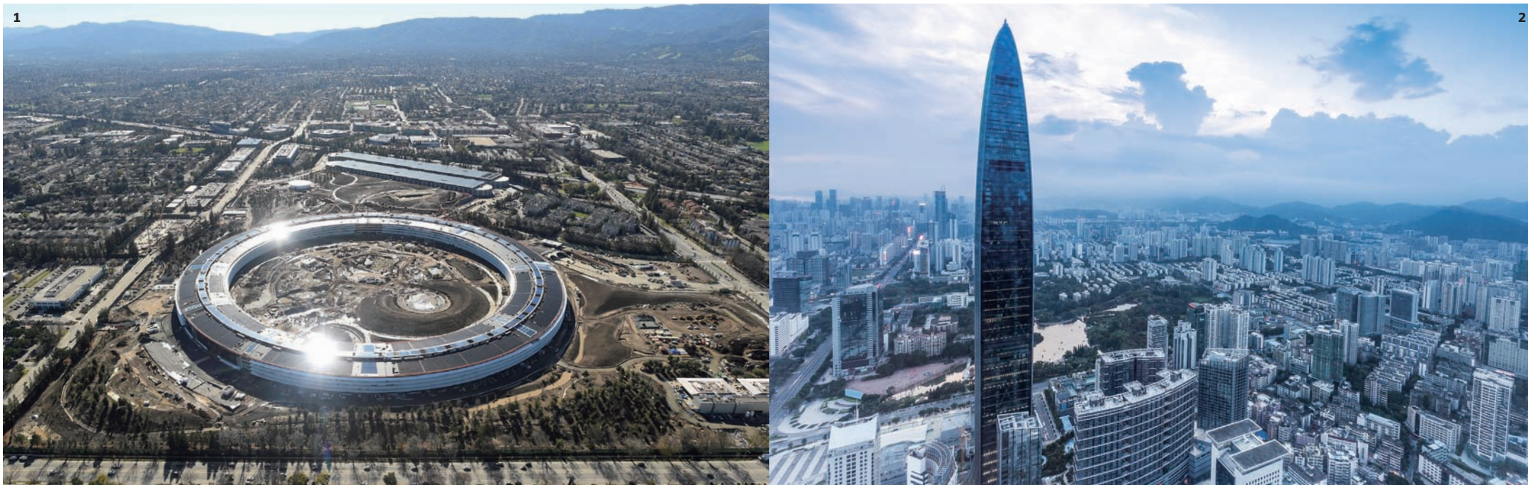
1 오리지널 실리콘 밸리는 넓고 낮게 펼쳐져 있다. 둥근 건물은 공사가 한창 진행 중인 애플 신사옥(캠퍼스2). 2 중국의 실리콘 밸리는 마천루다. 하드웨어의 실리콘 밸리로 불리는 선전의 모습. 평안 파이낸스 센터가 워낙 높이(600m) 다른 건물이 작아 보이는 것일 뿐이다.
